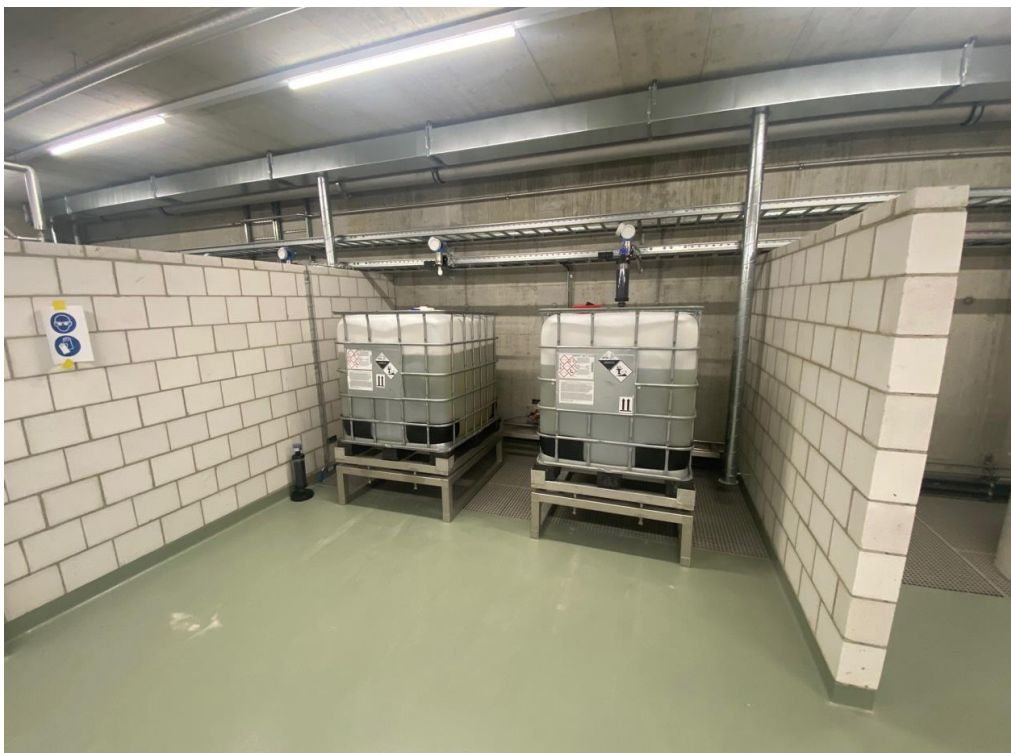
13. Erste Chemiecontainer (Javel) wurden angeliefert, 14. Februar 2024
