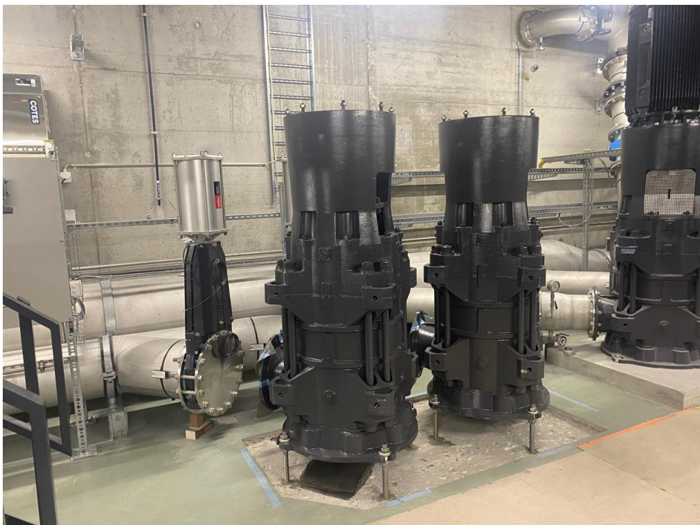
12. Montierte «Molchpumpen» im Bereich des Reinwasserpumpwerks (die Motoren oben sind noch nicht montiert worden), 14. Februar 2024
