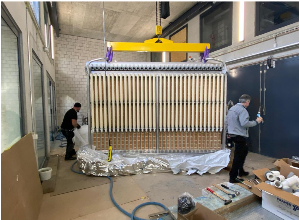
8. Montage der Ultrafiltrations-Kassetten, 6. Februar 2024
