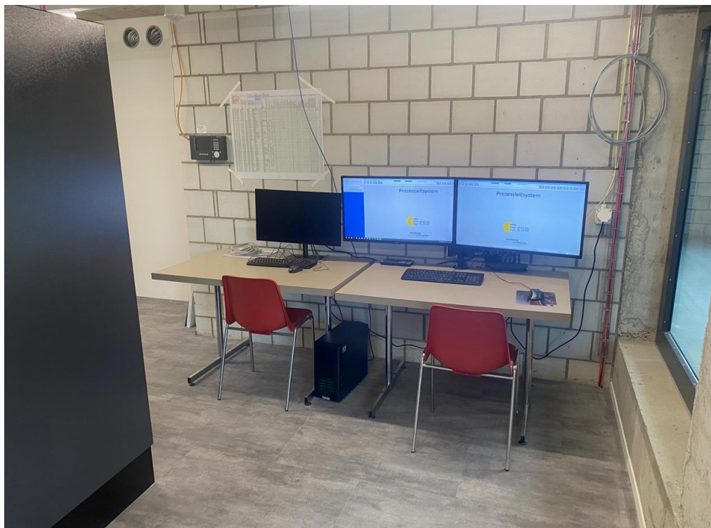
16. Provisorische Leitstelle. Anmerkung: Die definitive Leitstelle wird erst in der zweiten Bauetappe erstellt. 14. Februar 2024
