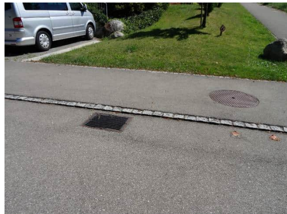
Abschnitt A : Einlaufschacht und Rost in Ordnung
