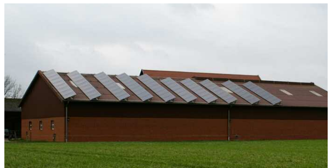
Aufgeständerte Solaranlage (&gt; 20 cm)
